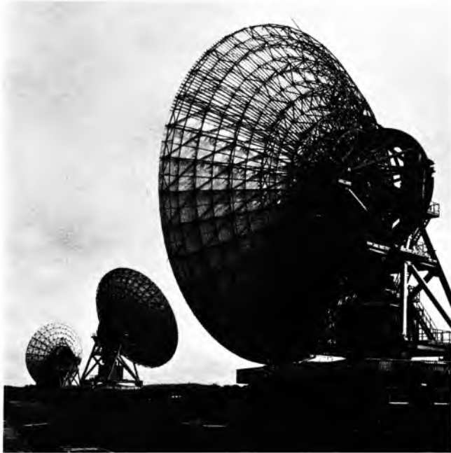
Sl. 40. Zemaljska stanica komunikacijskih satelita sustava INTELSAT s promjerom otvora antenskog reflektora 32 m
