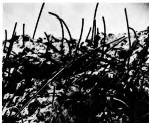
Sl. 2. Izgled prijelomne površine mikroarmiranog betona
