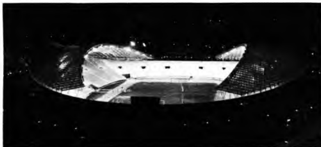
Sl. 23. Sustav linearne rasvjete na Poljudu u Splitu ovješan o krovnu konstrukciju
