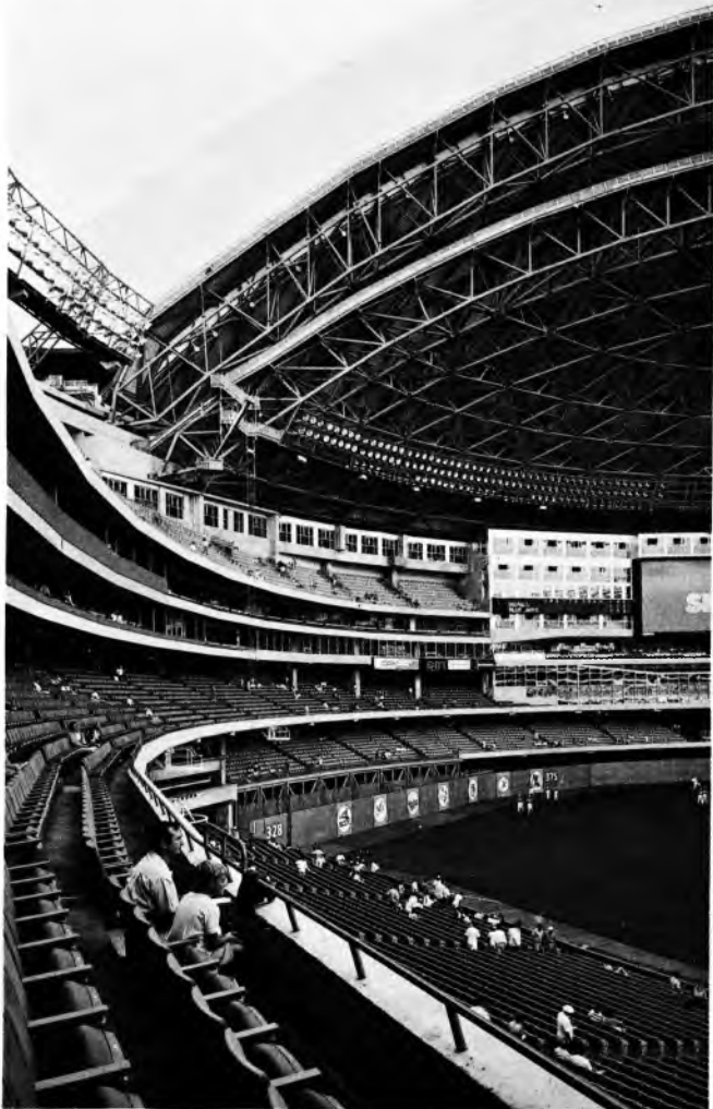
Sl. 19. Stadion SkyDome u Torontu s pomičnim krovom
