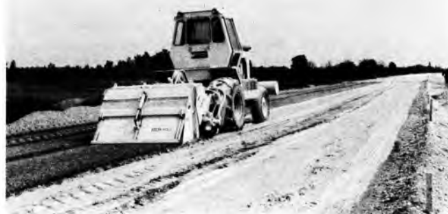
Sl. 7. Sitrjenje i rahljenje tla rotofrezerom
