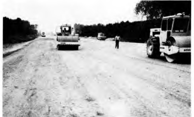
Sl. 9. Valjanje sloja cementom stabiliziranog šljunka
