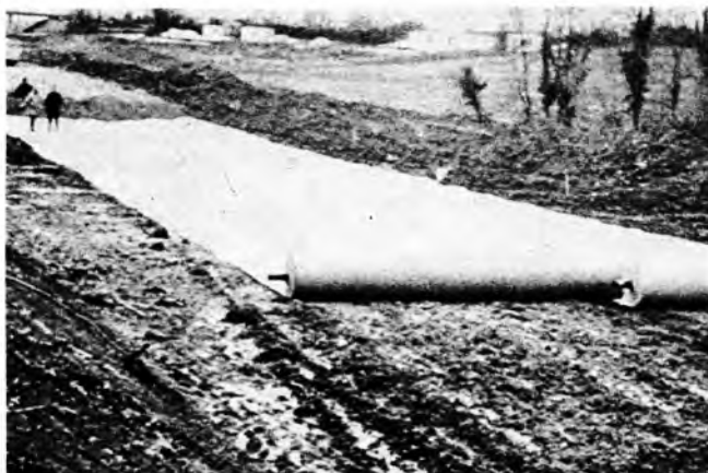
Sl. 13. Polaganje netkanog tekstila na provlaženo tlo
