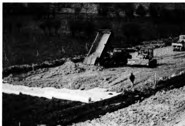
Sl. 14. Razastiranje zrnatoga kamenog materijala preko netkanog tekstila i zabijanje
