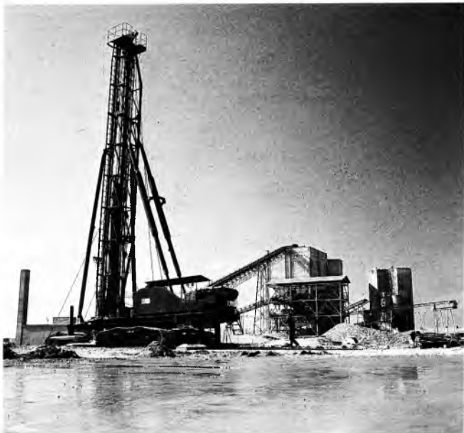
Sl. 23. Stroj za izvedbu pilota tipa Franki
