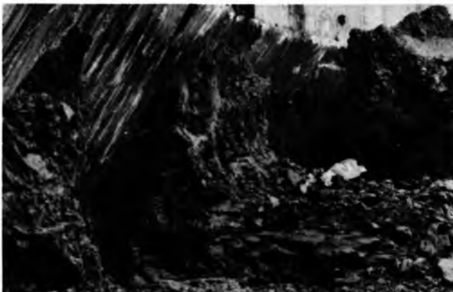
Sl. 19. Potkopani nož istiskuje preostale potporne klinove u bunaru strojarne HE Obrovac
