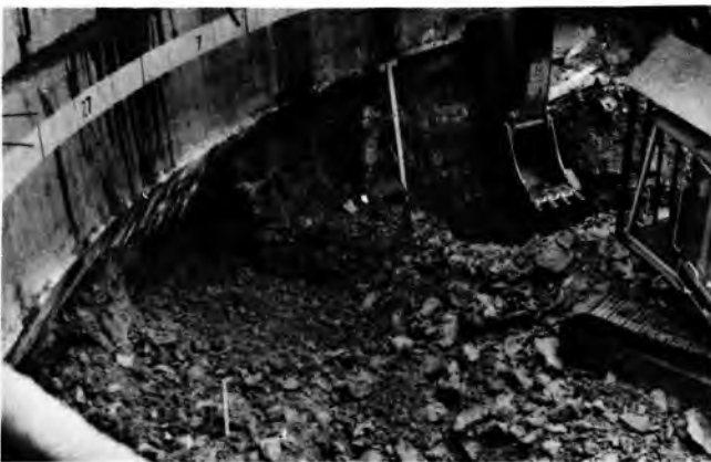
Sl. 18. Kapanje usjeka oko noža za spuštanje bunara strojarne HE Obrovac pomoću bagera
