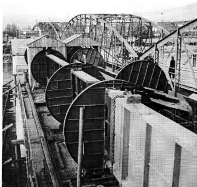
Sl. 1. Savski most u Zagrebu (1938), potpuno izgrađen zavarivanjem
