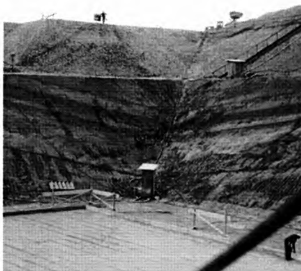
Sl. 5. Pogled na jugoistočni ugao građevne jame nuklearne elektrane u Krškom
